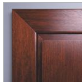
spojenie obložkových lišt pod uhlom 45°
