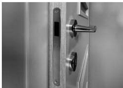
magnetický zámok v dverovom krídle
