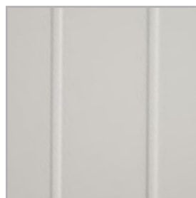
frézování na povrchu křídla
