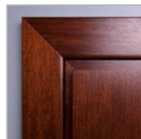
spojování lišt pod úhlem 45°
